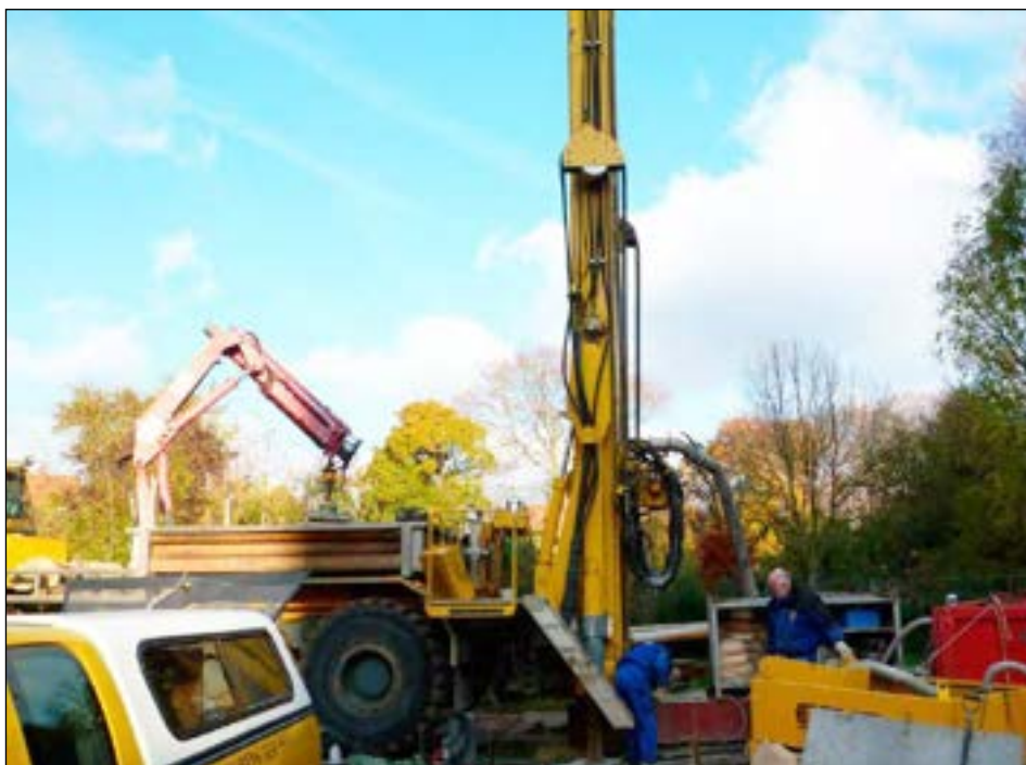
Moderne boreudstyr. Når boringen er gennemført, kræver et anlæg minimal vedligeholdelse. Hvis vandets tryk ikke kan drive anlægget, kræver det dog energi til en pumpe.
