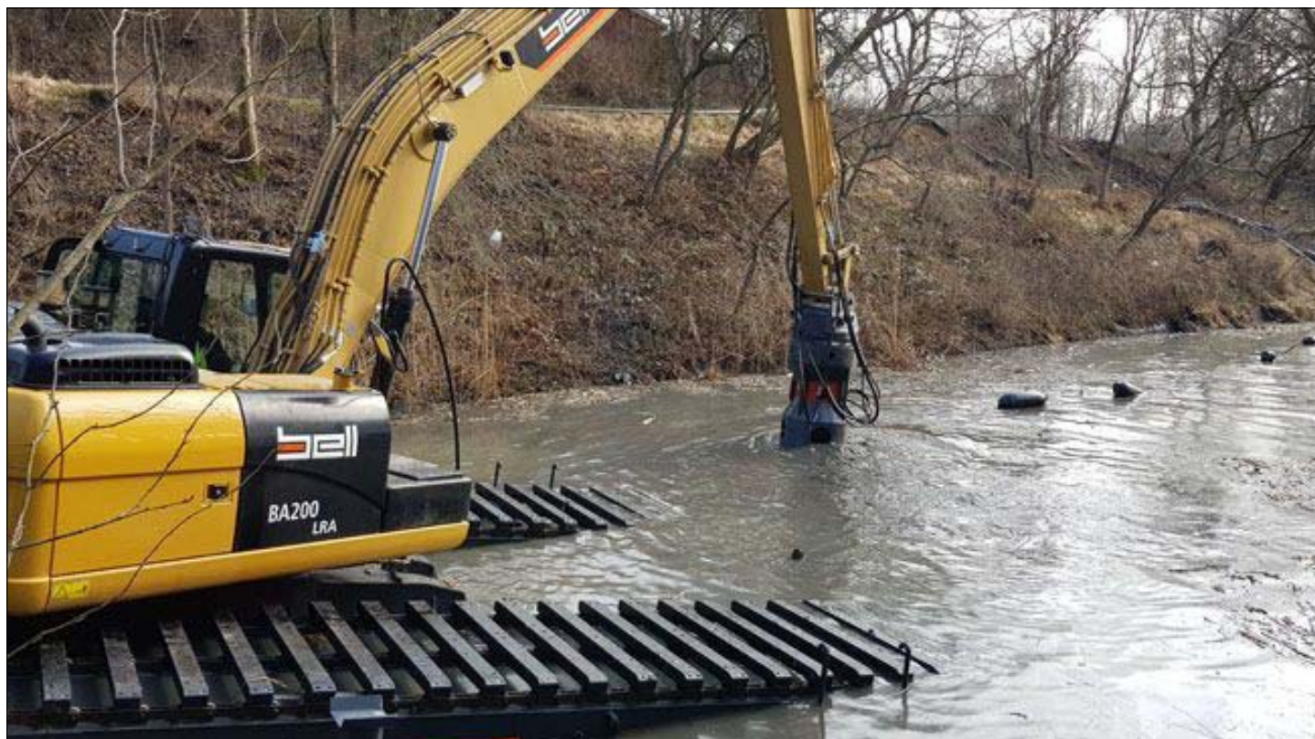
Sedimentfjernelse i fæstningskanalen i 2021. De to tidligere gange, hvor fæstningskanalen blev oprenset i 50'erne og 70'erne, blev kanalen tørlagt og udgravet med en gravko. I 2021 har man istedet valgt at opsuge sedimentet. Fordelen er, at det herved kan bortskaffes. Ulempen er, at alting bliver mudret op. Af samme grund er oprensning med opsugningsteknik uanvendelig i selve mosen. Foto: Jens Christian Elle.
