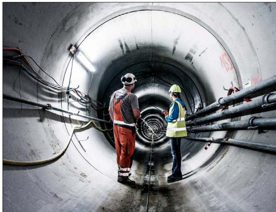
Svanemøllen Skybrudstunnel er færdig i 2031. Den bliver et stort og mange kilometer langt rør, som kan aflaste de almindelige kloakker ved skybrud. Forløbet heraf bliver y-formet, og det nordligste ben skal aflaste især Gladsaxe og Gentoftes Kommuner.
